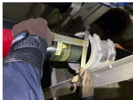
ケーブル移動量点検
