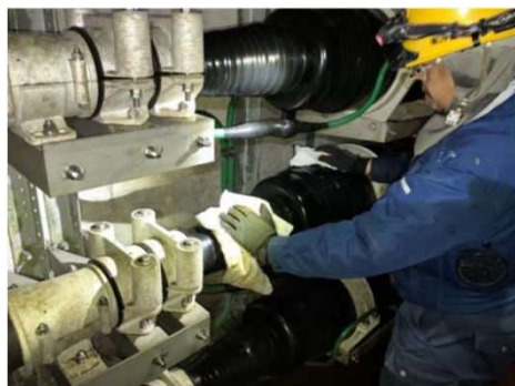
ケーブル外観点検
