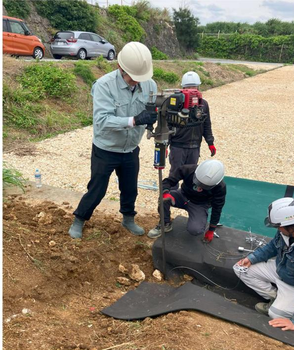
(写真1) 耐風性向上の為の特殊アンカーによる設置状況
