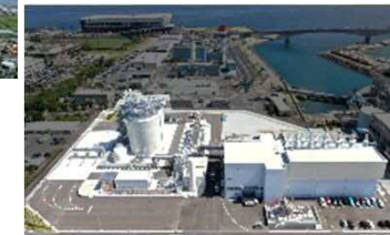
牧港ガスエンジン発電所（LNG）
