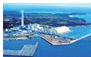
金武火力発電所（石炭）
