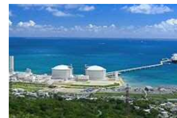
吉の浦火力発電所（LNG）
