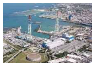
牧港火力発電所（石油）
