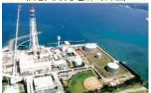
石川火力発電所（石油）
