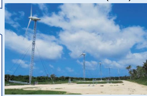
可倒式風力発電設備(トンガ)
