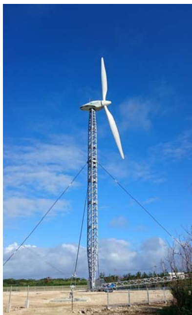
【写真 1：風車全景】
