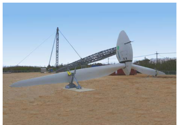
【写真 2：風車傾倒時】
