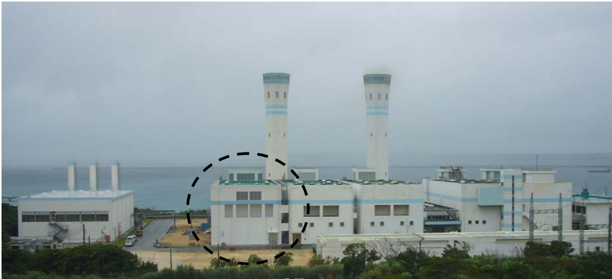
宮古第二発電所 5号発電設備建屋
