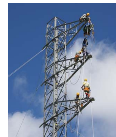
仮設鉄柱設置訓練
