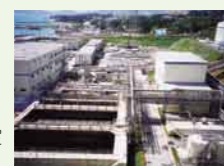
総合排水処理装置
