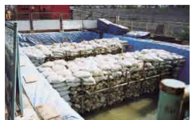
赤土等流出防止対策(浦添変電所新設工事)
