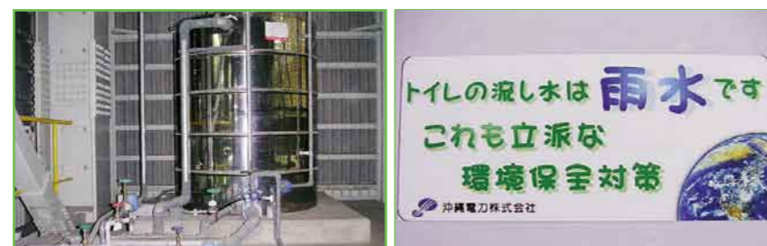
雨水を回収しトイレの流し水に利用(金武火力、宮古支店、八重山支店)
