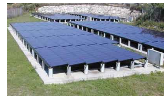
【北大東太陽光発電実証研究設備】 アモルファス太陽電池は、夏場の温度上昇に強く沖縄の気候に最も適した太陽電池であることが実証されています。本格的普及に向け研究を行っています。
