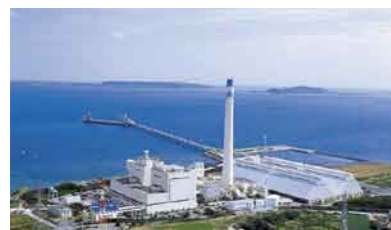
【貝志川火力発電所】
