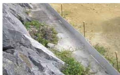
オカヤドカリ類進入防止柵(吉の浦火力発電所 建設工事)
