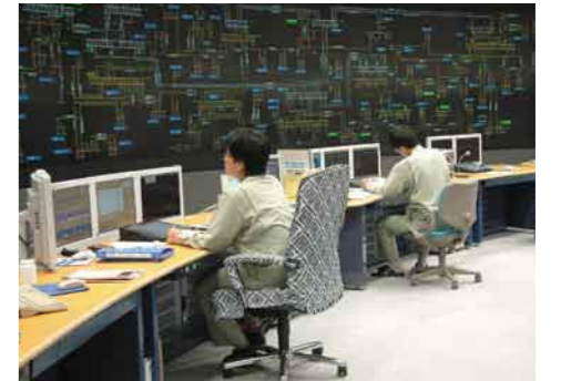
高効率運用を行っている給電指令所
