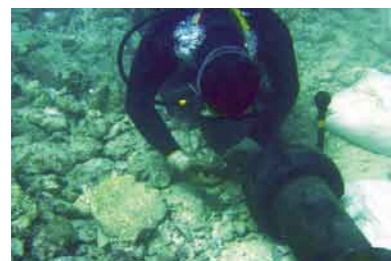
【環境に配慮した海底ケーブル設置(今帰仁〜伊是名間)】
