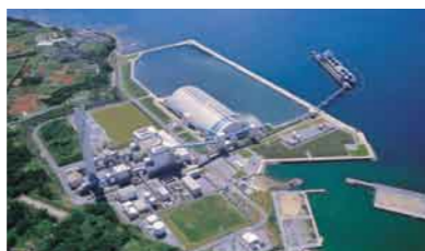
【金武火力発電所】
