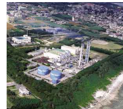
緑の発電所(石垣第二発電所)
