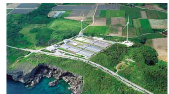
【宮古太陽光発電実証研究設備(後方は、沖電新エネルギー開発(株)の風力発電設備)】 2003年の台風14号で太陽電池パネルの約3割が被害を受けましたが、残りの健全部分の太陽電池パネルを使用し、2006年3月に運転を再開しました。
