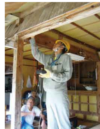
独居老人宅の電気設備点検
