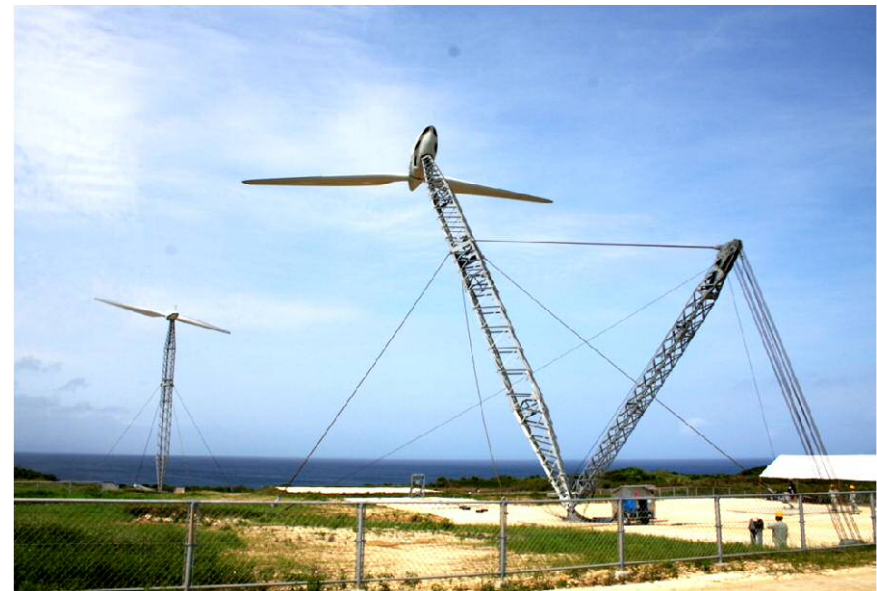
◀◀ 可倒式風力設備（傾倒作業中） ▶▶ 【波照間島】
