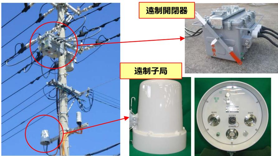
遠制開閉器：高圧線の電線路を「入」「切」する装置
