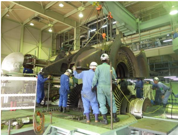
発電所の定期点検（牧港火力発電所）
