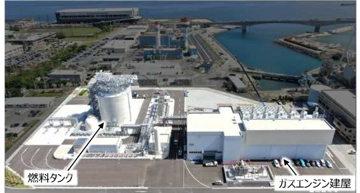
↑ 牧港ガスエンジン発電所全景
