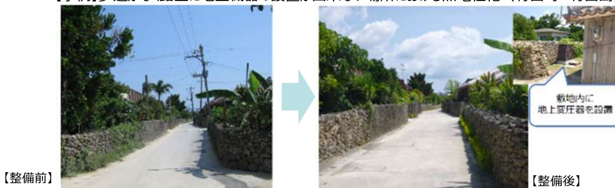
【事例】歩道がなく路上に地上機器の設置が出来ない場所における無電柱化（竹富町 竹富島）
