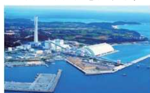
金武火力発電所（石炭）
