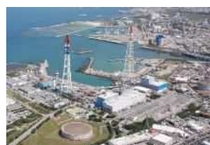
牧港火力発電所（石油）
