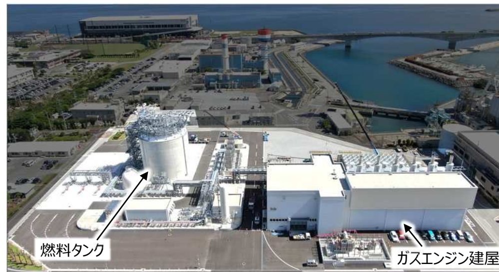
↑ 牧港ガスエンジン発電所全景
