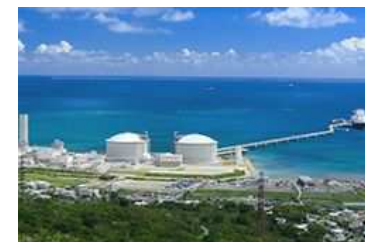
吉の浦火力発電所（LNG）
