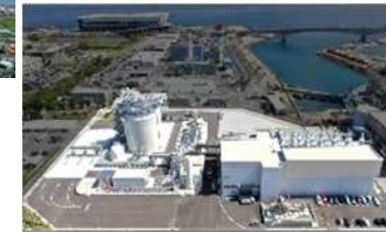
牧港ガスエンジン発電所（LNG）
