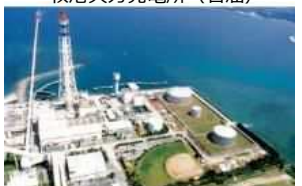
石川火力発電所（石油）
