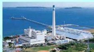
当社石炭火力発電所 (具志川火力、金武火力)
