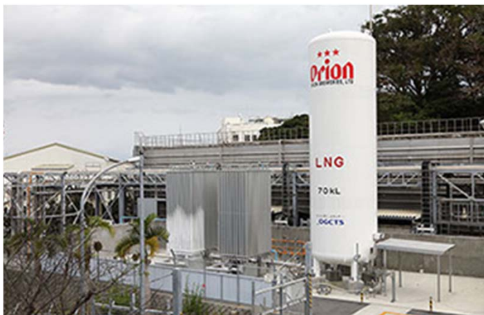
LNGサテライト設備 ▲
