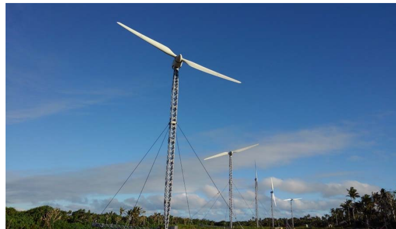
▲ トンガ王国へ納入した可倒式風力発電設備
