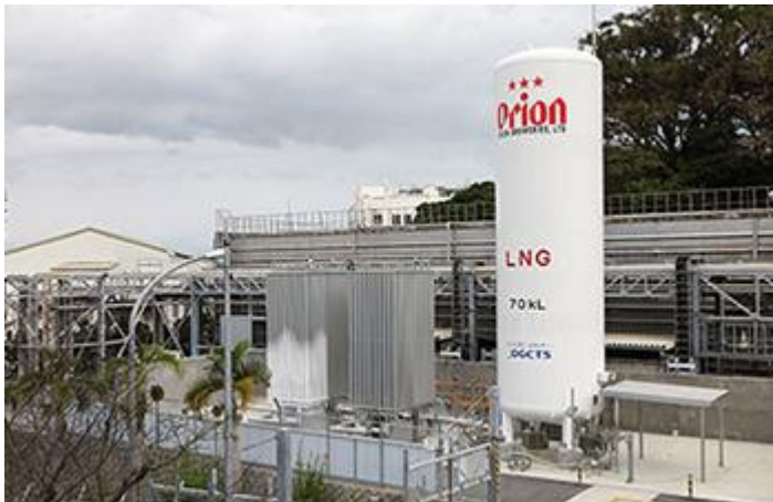
LNGサテライト設備 ▲
