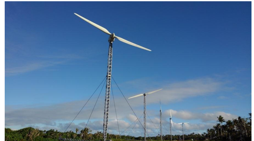
▲ トンガ王国へ納入した可倒式風力発電設備
