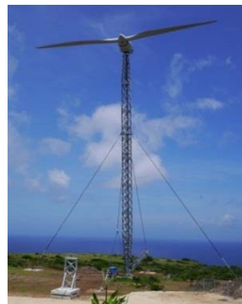
▲納入予定の可倒式風力発電設備 (左：粟国島、右：波照間島)
