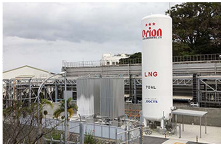
LNGサテライト設備 ▲
