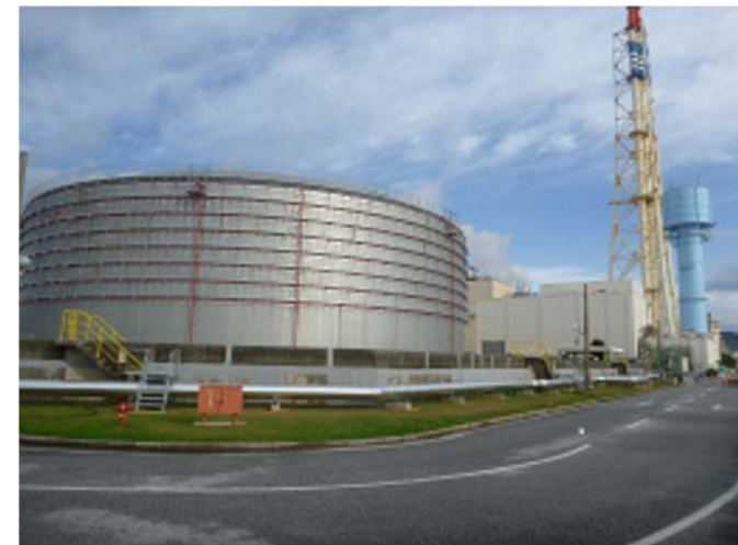
石川火力発電所内 重油タンク
