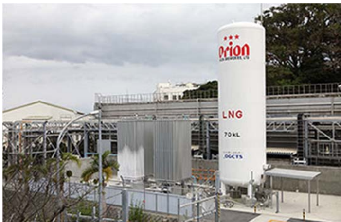
LNGサテライト設備 ▲
