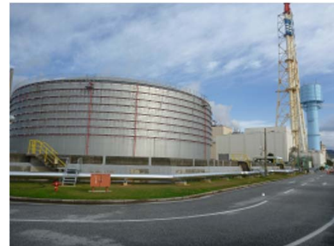
石川火力発電所内 重油タンク (15,000kl)
