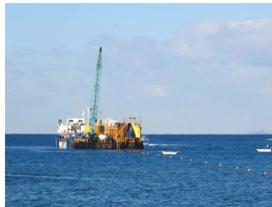
[敷設専用台船による敷設工事の様子]
