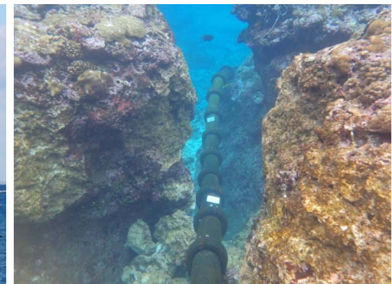
[海底ケーブル敷設状況]
