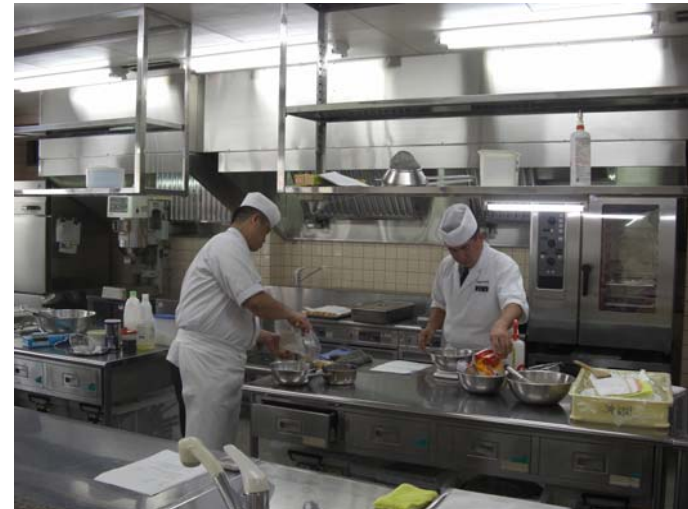
業務用電化厨房機器を導入した施設の厨房
