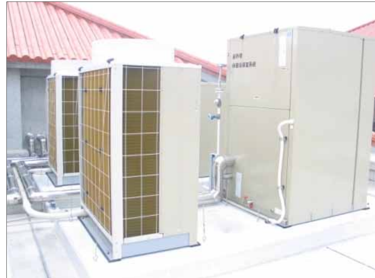
電気式空調システム
