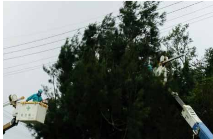
樹木接触伐採の様子
