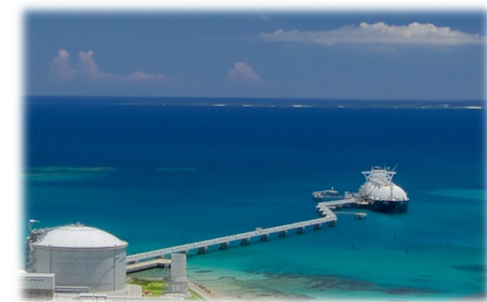
▲吉の浦火力発電所におけるLNG受入
