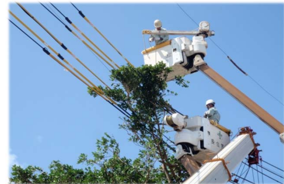
▲日頃の設備巡視、飛来物低減、樹木伐採
