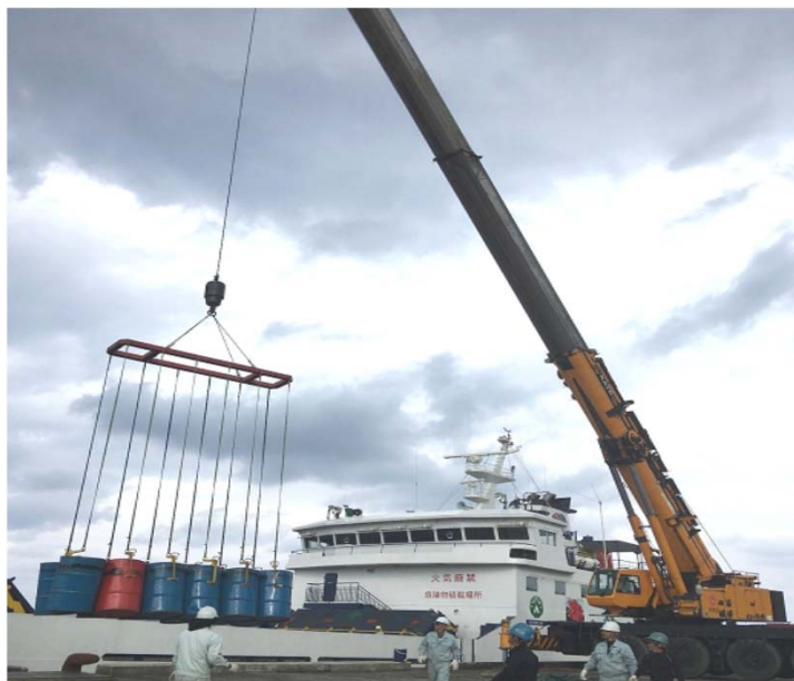
«燃料の受入（A重油のドラム缶荷揚げ）» 【南大東島】
