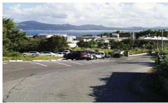
駐車場新設工事施工例
