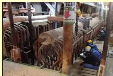
高経年化対策工事 (ボイラ再熱器管更新)
