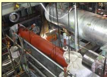
高経年化対策工事 (ボイラ2次過熱低減器更新)
