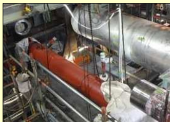
高経年化対策工事 (ボイラ2次過熱低減器更新)
