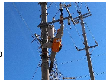
▲ 配電技能インストラクター研修の様子
