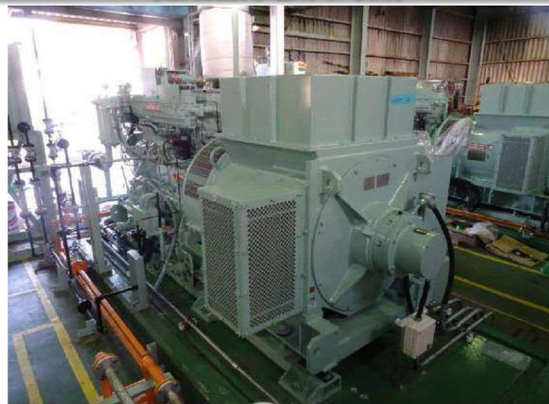
◀ 高効率の内燃力発電機 ▶ 【渡名喜発電所 9号機】(2019年3月運開)
