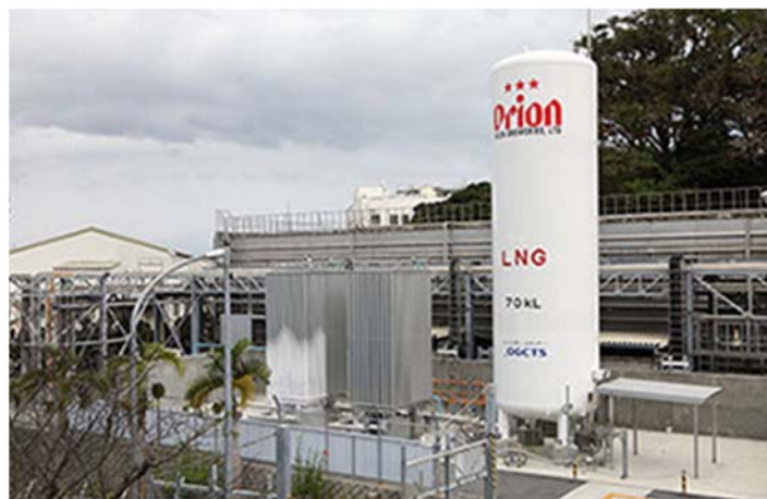
LNG satellite facilities ▲
