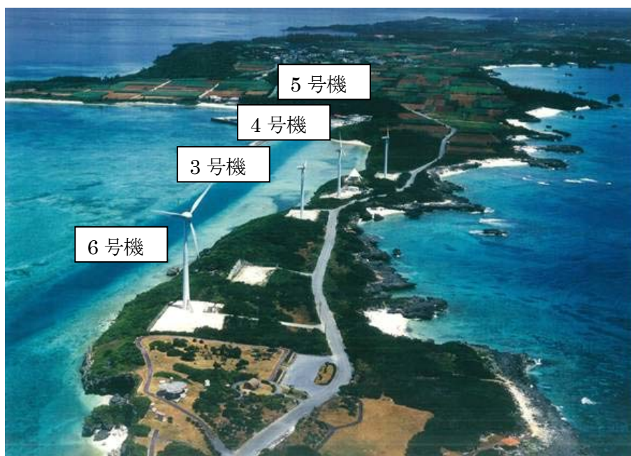
図 3.1-1 狩俣風力の被害前状況写真
