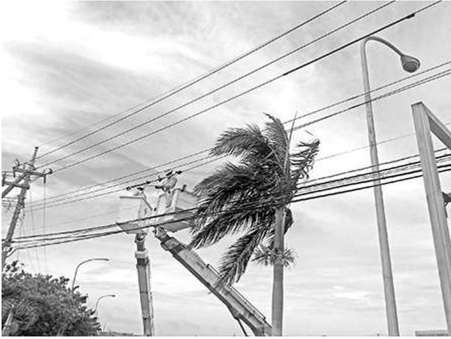
復旧作業の様子
