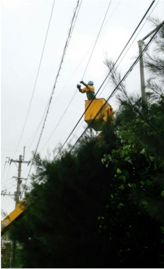
うるま市高江洲における樹木が接触した電線の補修作業
