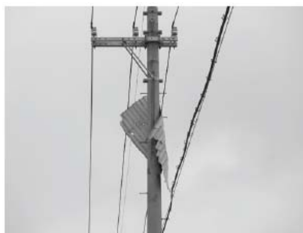
電柱に絡みついたトタン
