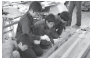
2 液混合型の常温硬化樹脂を使って手作業で纖維へ含浸させる「ウェットレイアップ」にも取り組んだ。私たちはエボキシ樹脂とポリスチレン樹脂を使用した。気温が高いと硬化にかかる時間が短くなるため、沖縄での作業には経験と高い技術が求められる。
