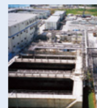
▲総合排水処理装置
