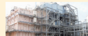
▲排煙脱硫装置
