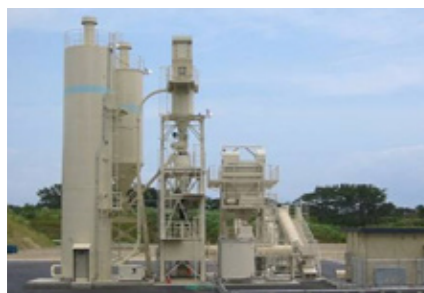
▲頑丈土(がんじゅうど)製造プラント
