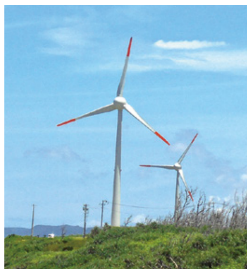
伊江島第二風力発電所
