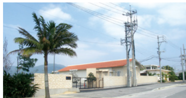
▲名蔵配電塔 名蔵配電塔(石垣島)は、石垣市風景づくり条例に対応するため、赤瓦の屋根を採用し、景観に配慮した建屋外観としました。
