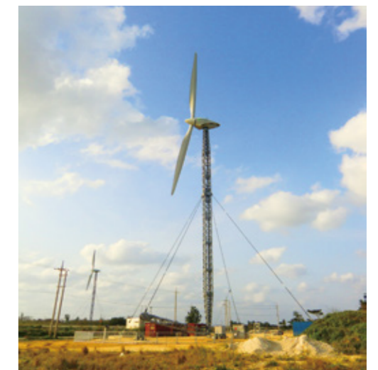
▲可倒式風力発電システム(多良間島)
