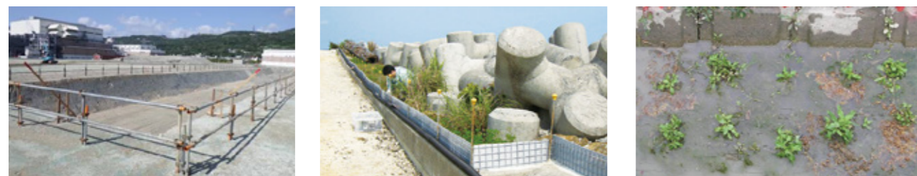
▲赤土等流出防止対策(吉の浦マルチガスタービン発電所 建設工事) ▲オカヤドカリ類保全対策(吉の浦火力発電所 建設工事) ▲建設予定地外に移植後のカワチシャ(吉の浦火力発電所 建設工事)
