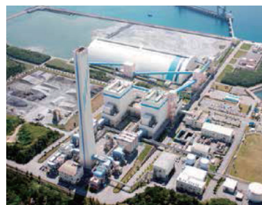
▲金武火力発電所（石炭）
