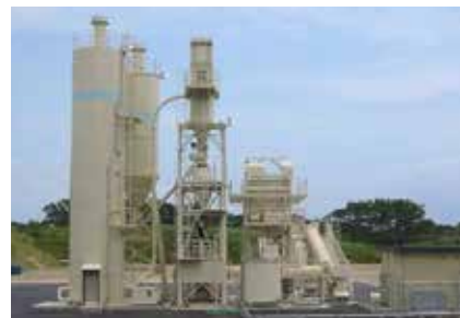
▲頑丈土(がんじゅうど)製造プラント
