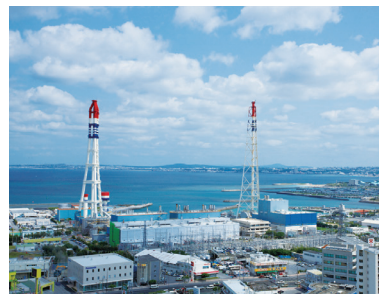
▲牧港火力発電所（石油）
