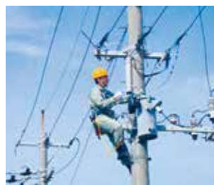
▲配電設備復旧訓練
