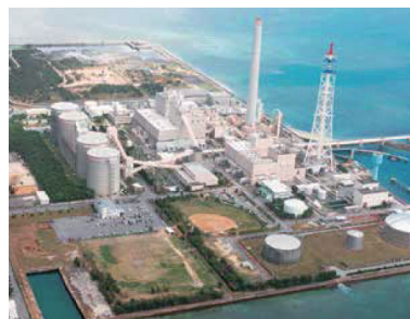
▲石川火力発電所（石油）
