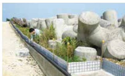
▲オカヤドカリ類保全対策 (吉の浦火力発電所 建設工事)
