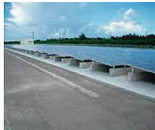
・太陽光発電 250kW ・リチウムイオンキャパシタ 250kW
