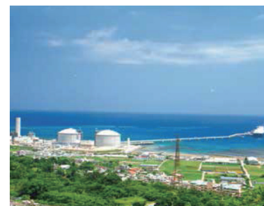
▲吉の浦火力発電所（LNG）
