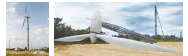
▲多良間可倒式風力発電設備・傾倒時
