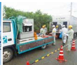
▲発電機車及び移動変圧器車取扱訓練
