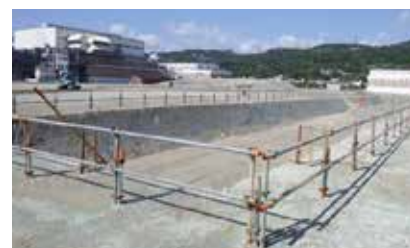
▲赤土等流出防止対策 (吉の浦マルチガスタービン発電所 建設工事)
