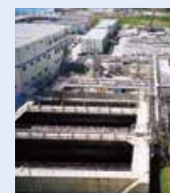
▲総合排水処理装置
