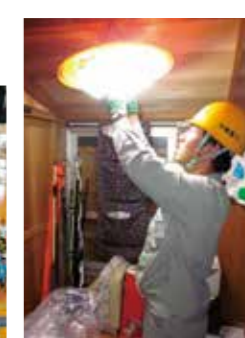
▲地域奉仕活動(電気設備無料点検)
