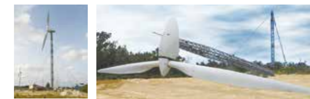
▲多良間可倒式風力発電設備・傾倒時
