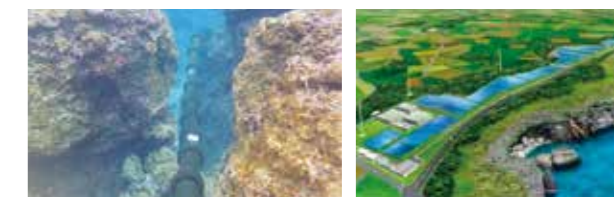
▲渡嘉敷海底ケーブル敷設状況
