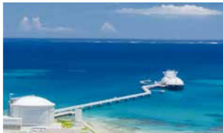
▲吉の浦火力発電所：LNG船による受入
