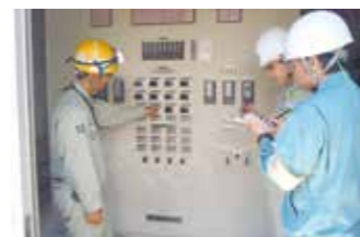
▲吉の浦火力発電所での実習風景
