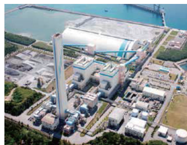
▲金武火力発電所（石炭）
