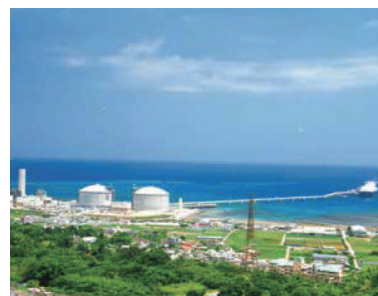
▲吉の浦火力発電所（LNG）
