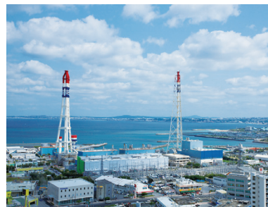
▲牧港火力発電所（石油）
