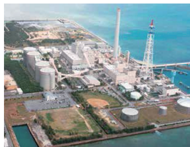
▲石川火力発電所（石油）
