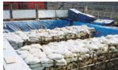
▲赤土等流出防止対策(浦添変電所 新設工事)
