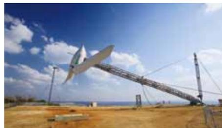
▲可倒式風力発電システム(南大東島)
