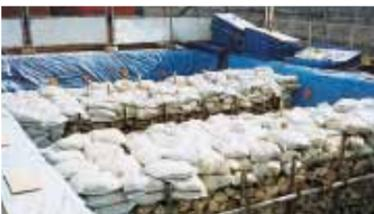
▲赤土などの流出防止対策(浦添変電所 新設工事)
