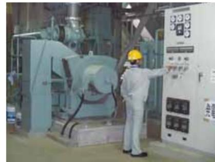
万が一、送電系統が遮断されて発電所の電源を喪失した場合に発電所の保安電源を確保できるように、非常用発電機の起動確認を行っています。
