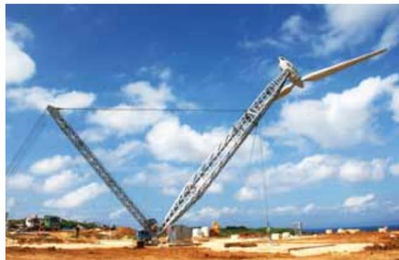
▲可倒式風力発電設備(波照間島)
