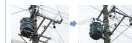
変台式からハンガー式にすることにより、地震動による柱上変圧器の傾斜および落下を防止しています。
