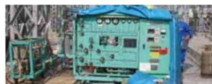
◀SF<sub>6</sub>ガス回収装置における回収作業
