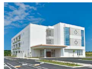
沖縄IT津梁パーク6号棟
