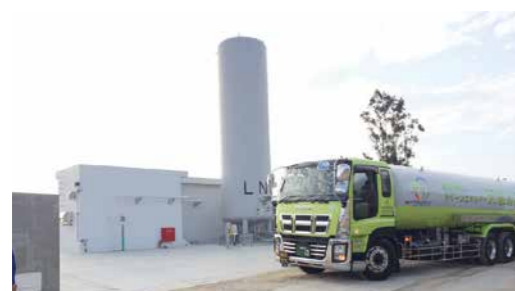
アワセ天然ガス供給センター
