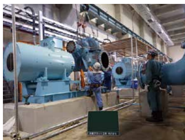
送水ポンプ分解点検
