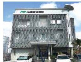
沖縄給油施設新社屋新築工事
