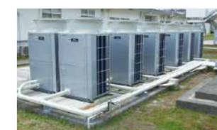
省エネ設備改修工事
