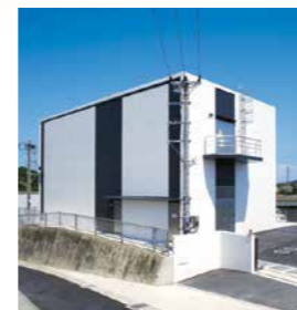
(仮称)機器室新築工事(PCa+S構法)
