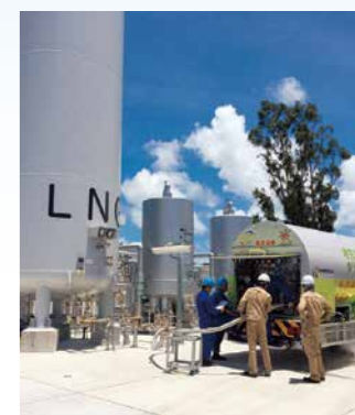
▲アワセ天然ガス供給センター
