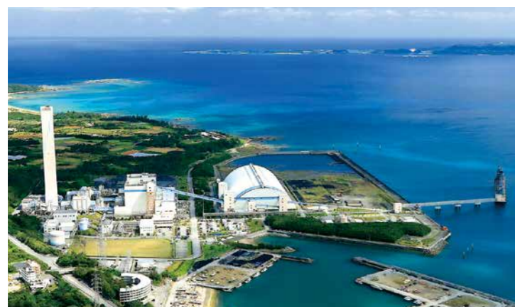
金武火力発電所
