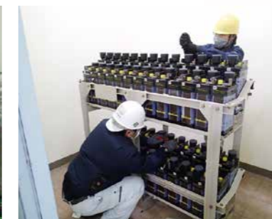
直流電源装置(蓄電池取替)
