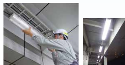
LED照明設置工事▶
