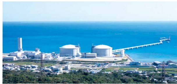
吉の浦火力発電所の全景
