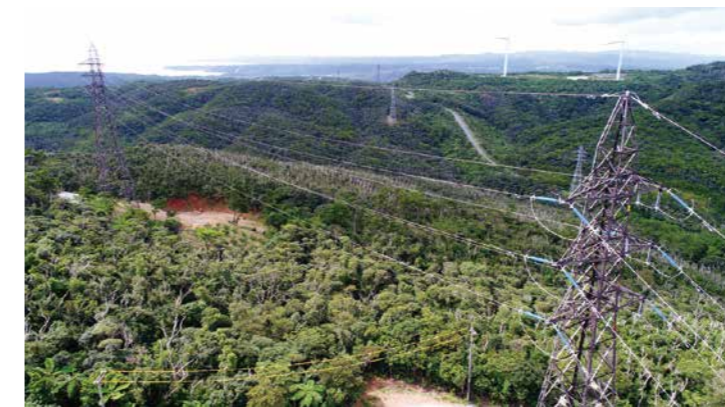
架空送電線路
