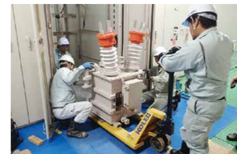
特高VCT取替工事
