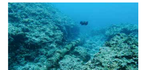
水中ドローンを利用した設備点検
