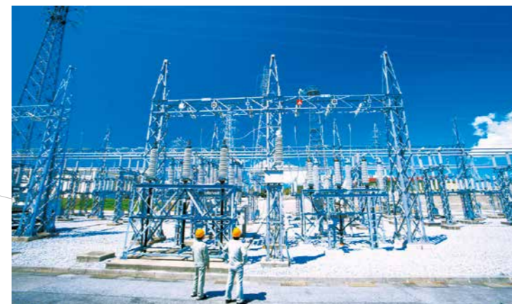
栄野比変電所
