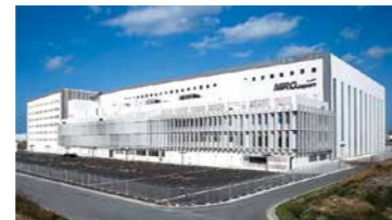
航空機整備基地新築工事(事務所棟建築4工区)
