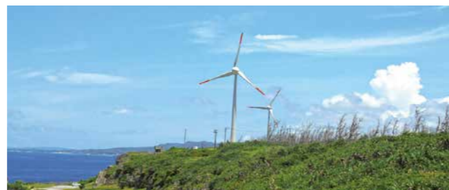
▲伊江島第二風力発電所
