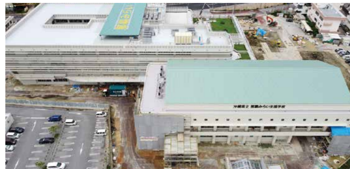
県立那覇A特別支援学校(仮称)新築工事(建築3工区)
