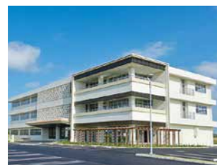
沖縄IT津梁パーク5号棟
