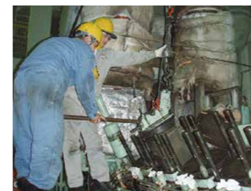
発電設備関連事業
