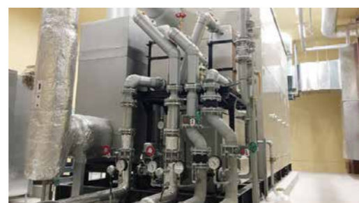
自家用発電システム
