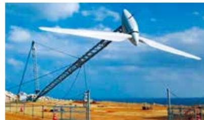
可倒式風力発電システム
