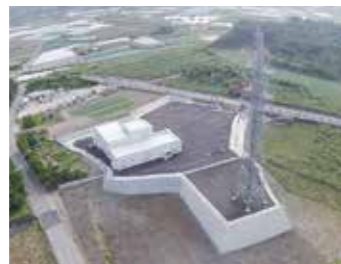
真壁変電所新設工事
