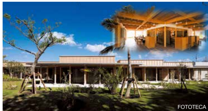
(国)杏月会 空の森プロジェクト新築工事
