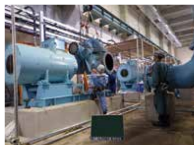
送水ポンプ分解点検
