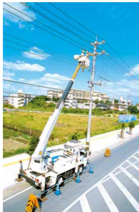
配電線のメンテナンス
