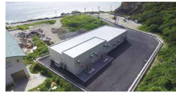
渡嘉敷配電塔
