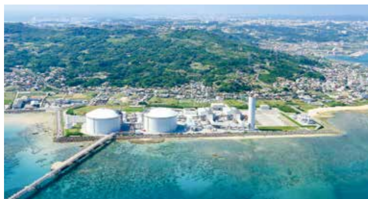
吉の浦火力発電所
