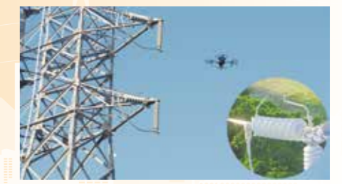
ドローンをを用いた調査 ※画像は訓練用鉄塔
