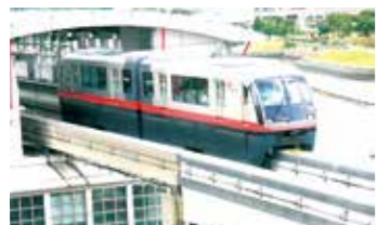
沖縄都市モノレール(株) 保守点検工事
