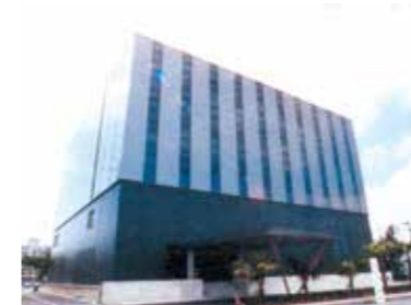
FRT IDCビル
