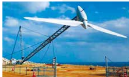
可倒式風力発電システム（建設）
