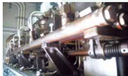
自家用発電システム
