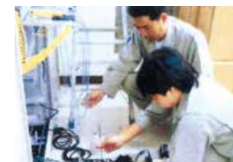
光ケーブル接続工事
