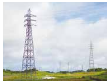
真壁線新設工事
