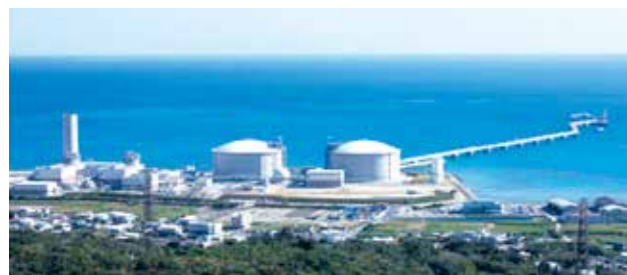
吉の浦火力発電所の建設工事
