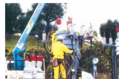
VCT 取替工事
