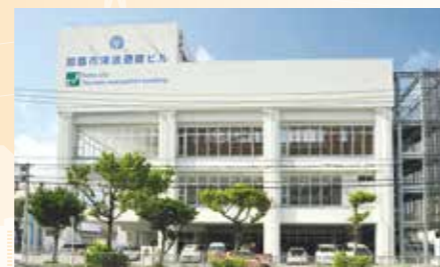
那覇市津波避難ビル建設工事
