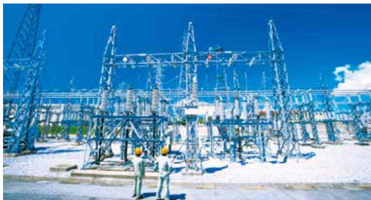
栄野比変電所
