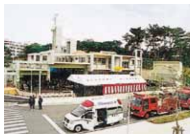
浦添市消防署内間出張所建設の機械設備工事を施工
