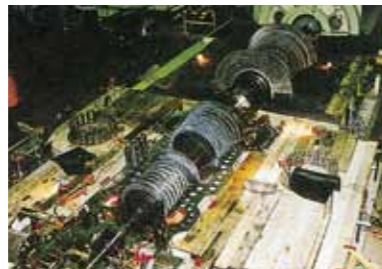
牧港火力発電所タービン分解点検
