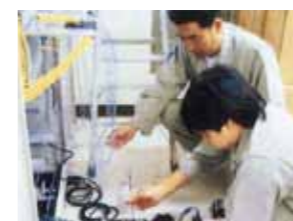
光ケーブル接続工事
