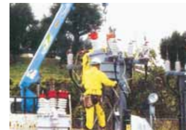
VCT取替工事
