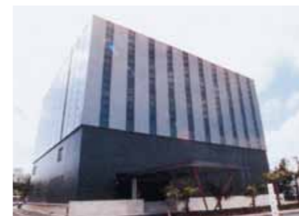
FRT IDCビル
