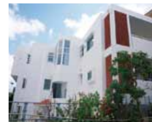
石川様住宅兼共同住宅新築工事 (建築工事)
