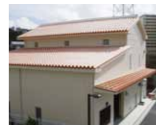
繁多川変電所新設工事
