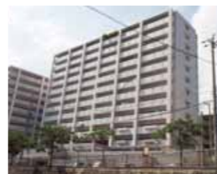
石嶺市営住宅第一期建替工事 (電気・2工区)
