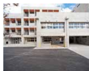
上山中学校改築工事 (校舎・建築1工区)
