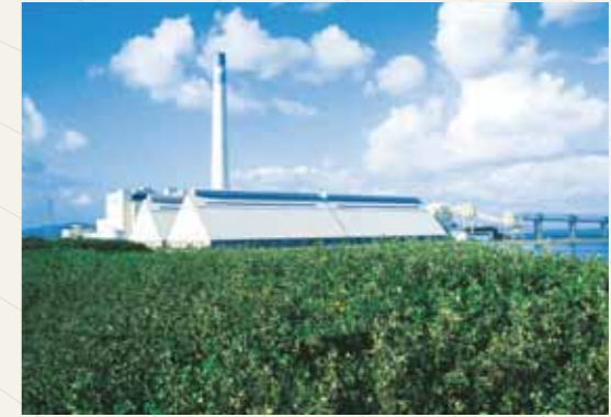
具志川火力発電所
