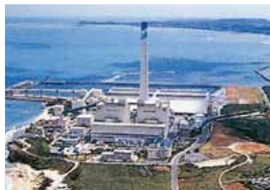
具志川火力発電所建設へ参加
