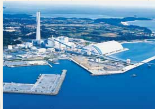
金武火力発電所
