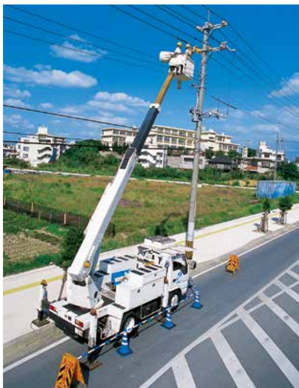
配電線のメンテナンス
