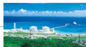
吉の浦火力発電所
