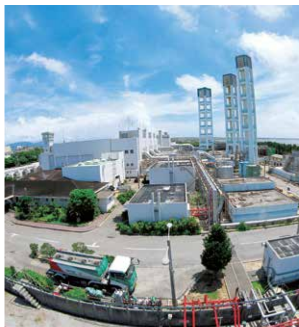
石垣第二発電所
