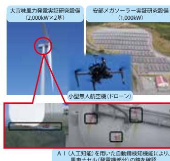
ドローンによる点検
