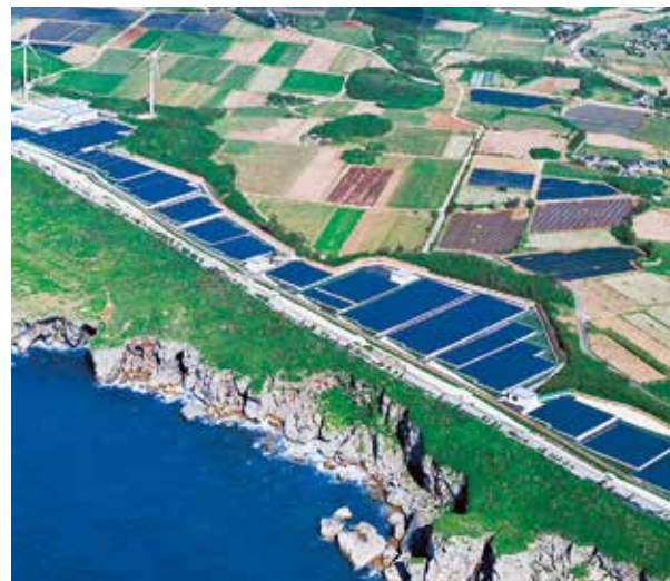
宮古島メガソーラー実証研究設備
