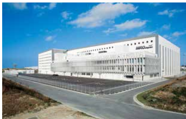
航空機整備基地新築工事（事務所棟建築4工区）：(株)沖電工
