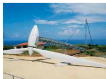
可倒式風力設備（傾倒時）【粟国島】
