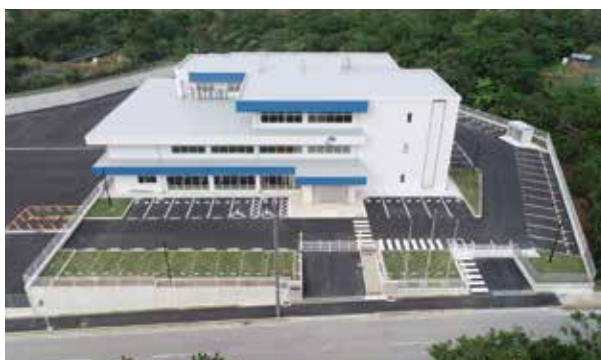
おきでん名護ビル新社屋：沖電開発(株)（設計：(株)沖縄エネテック・施工：(株)沖電工）
