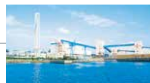
金武火力発電所
