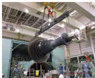
発電所のタービン定期点検
