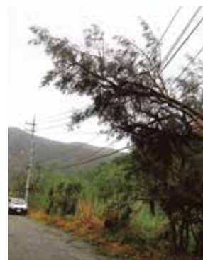
電線への樹木接触
