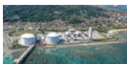
吉の浦火力発電所
