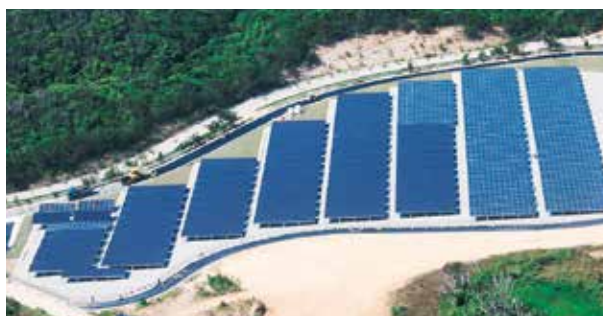
安部メガソーラー実証研究設備
