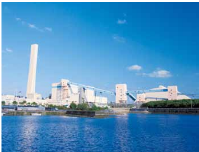
金武火力発電所
