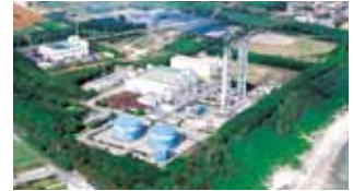
緑の発電所(石垣第二発電所)
