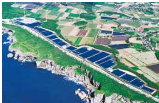
宮古島メガソーラー実証研究設備
