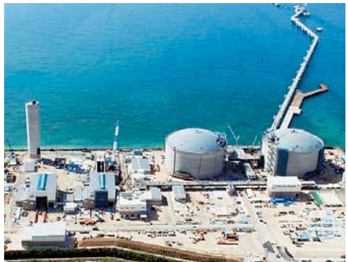
吉の浦火力発電所建設現場
