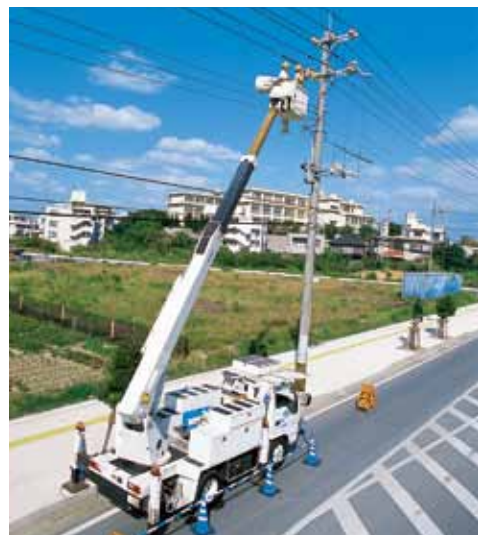
配電線のメンテナンス
