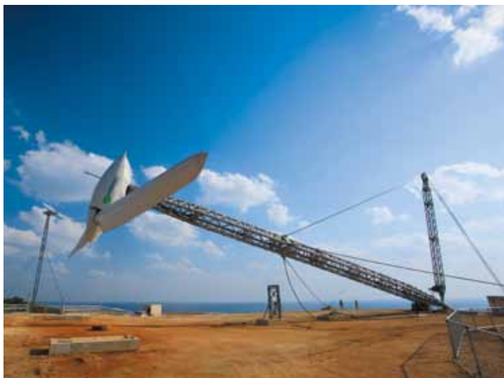
波照間可倒式風力発電設備
