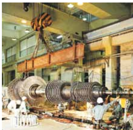
沖縄電力 牧港火力発電所タービン点検分解 沖縄プラント工業(株)
