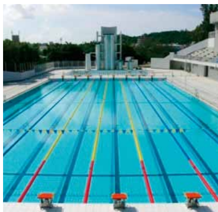
奥武山水泳プール改修工事:(株)沖電工
