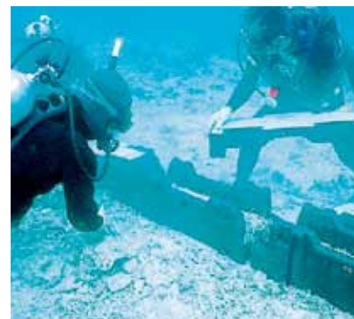
海底ケーブル
