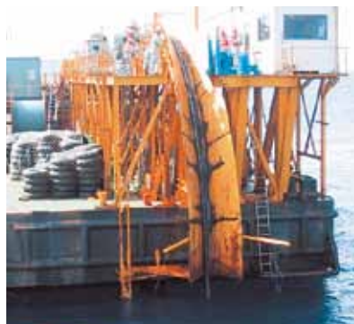
海底ケーブル敷設工事
