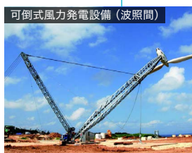
波照間可倒式風力発電設備 併入式
