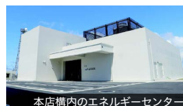
本店構内のエネルギーセンター
