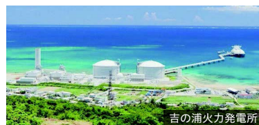
吉の浦火力発電所
