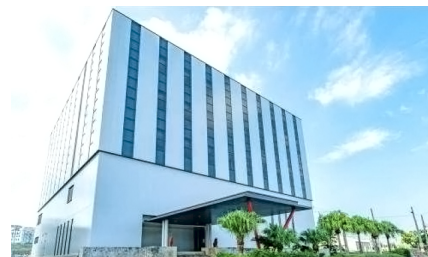
FRTインターネットデータセンター
