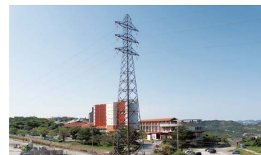
環境調和色送電線鉄塔（南城市）
