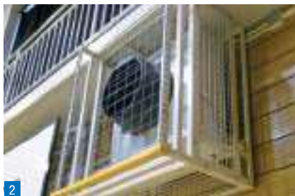
キャットウォーク下に吊下げ設置
