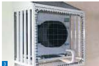
コンクリート壁に壁掛け設置
