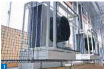
キャットウォーク上に床置き設置
