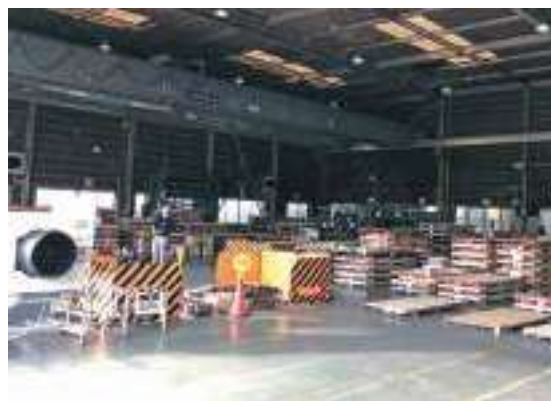
半開放の広い倉庫内に一体型2台と別置型4台を導入。直進性の高い風が作業スペースを冷やす。シャッターを閉め切ると倉庫全体がすごく涼しくなる
