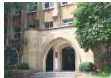
学習院大学西一号館
