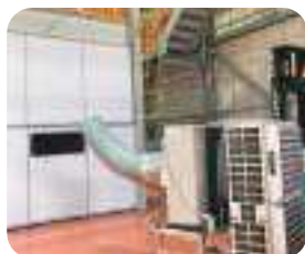
高所作業場（住友重機械モダン様）
